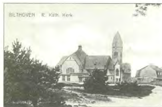
Zicht vanuit het oosten op de school, de kerk en het dubbele woonhuis Gregoriuslaan 15 en 17
