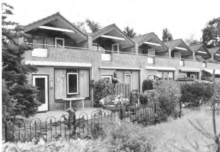
Prunuslaan voorheen Rietveldlaan. Atelierwoningen. (Foto Hans Haan 2006)
