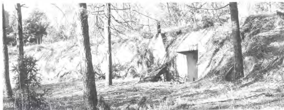
De hoofdbunker B1, afmeting 32 x 13 m.
