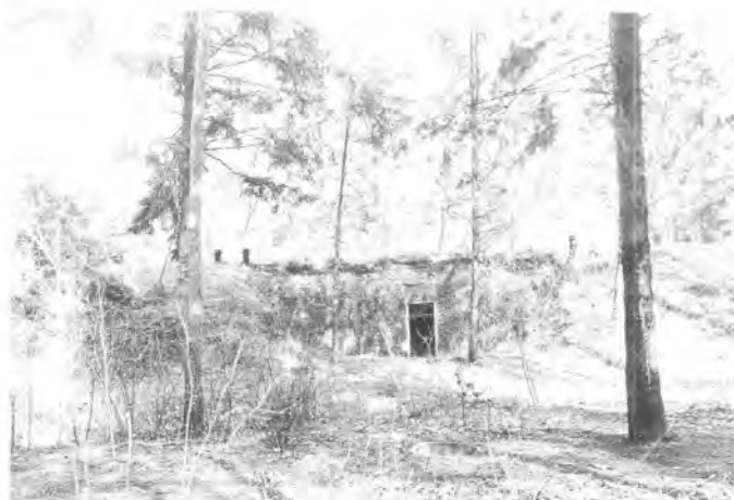
B 3 en B 4. Grote manschappenbunkers. In de meeste ruimten is een gat voor een schoorsteen, wat wijst op een woonfunctie.
