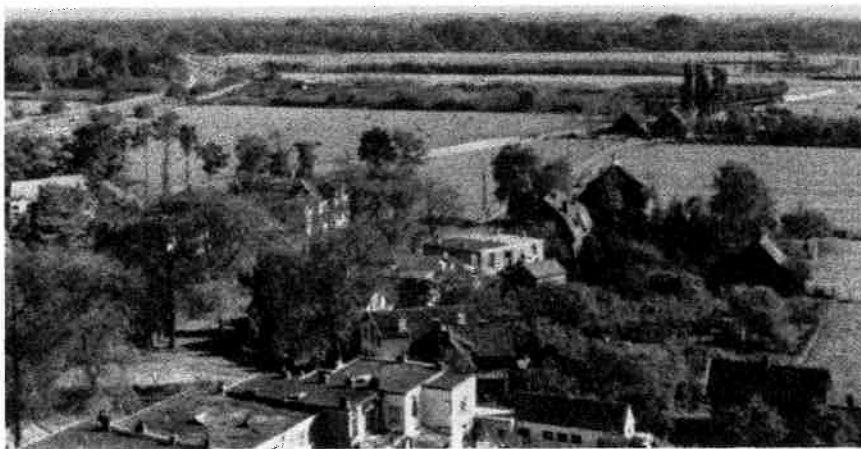
De eerste gebouwde huizen in het Kloosterpark met platte daken.
